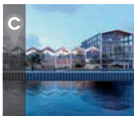
Lage: Lille Objekt: Panorama Übergang Nutzen/Lasten: 09/2021 (im Bau befindlich)
